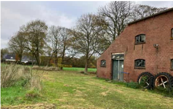
Achtererf van leegstaande en karakteristieke boerderij.
